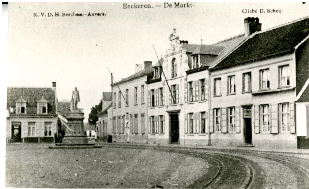
Het huis Sint-Joris aan de Markt in 1906 met de pas vernieuwde gevel (DAN-C12). De nieuwe gevel werd gebouwd door de vader van architect Henry Claes. Boven de eerste verdieping werd een fronton aangebracht met daar bovenop de beeltenis van Sint-Joris te paard. Het huis links van Sint-Joris is Den Hert en het huis rechts is Den Rozenhoed.
